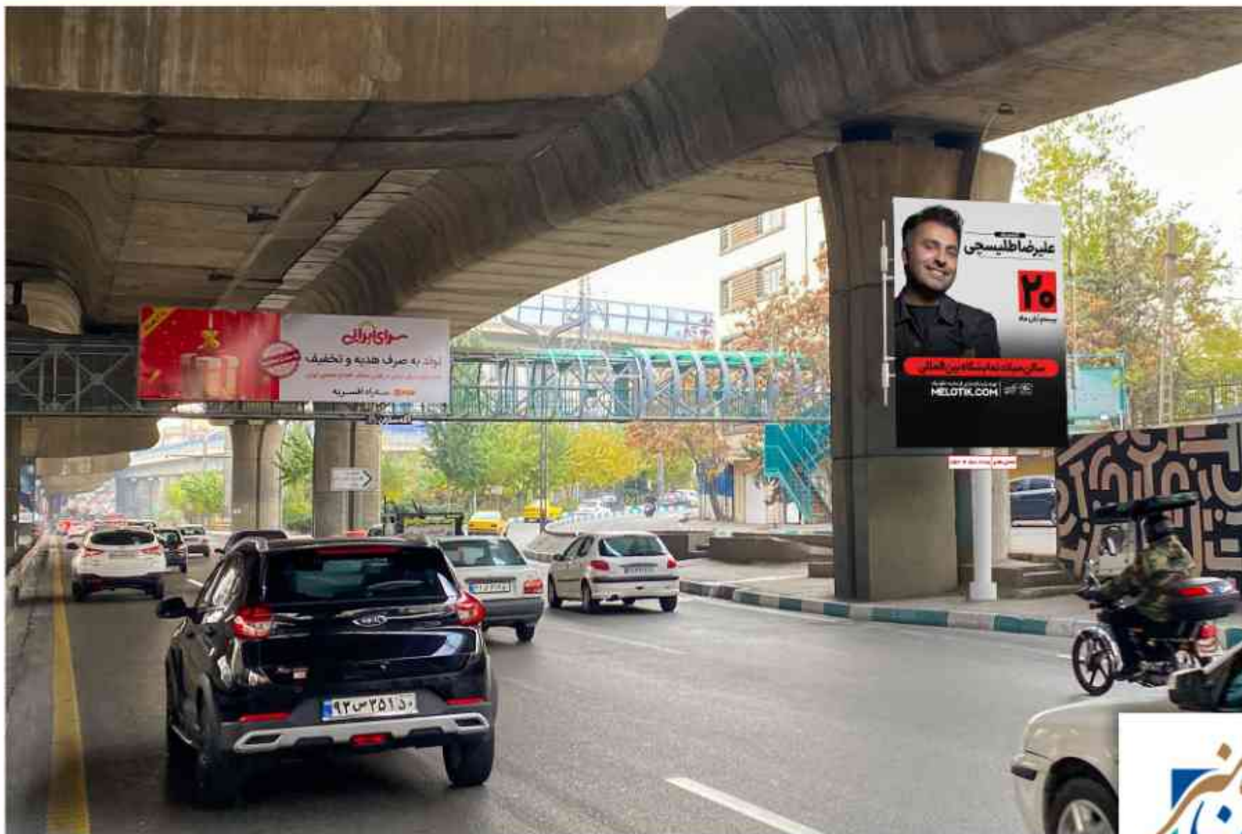
بزرگراه صدر، شرق به غرب، قبل از ورودی قیطریه
