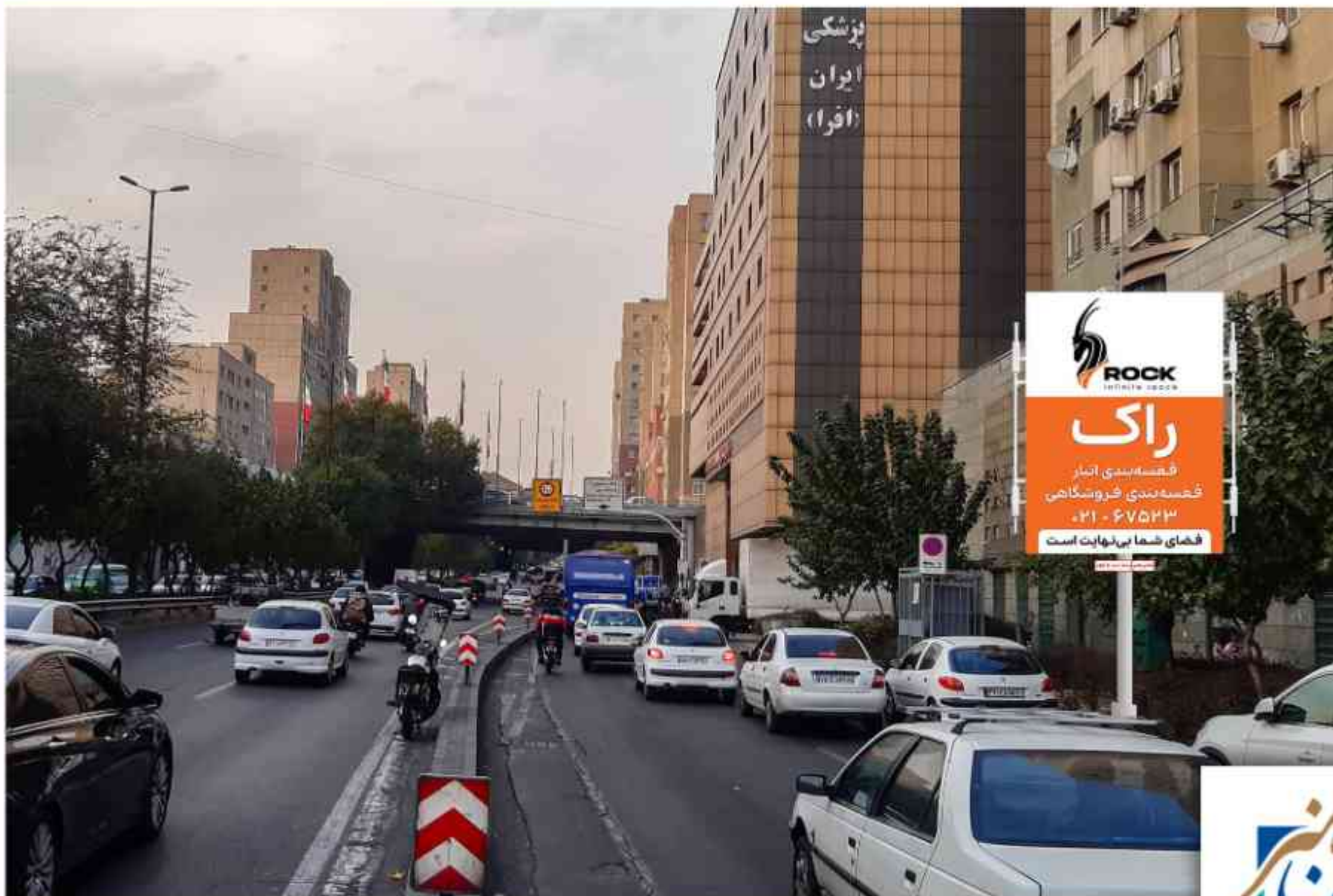
بزرگراه نواب، جنوب به شمال، قبل از پل شهرداری (سازه دوم)
