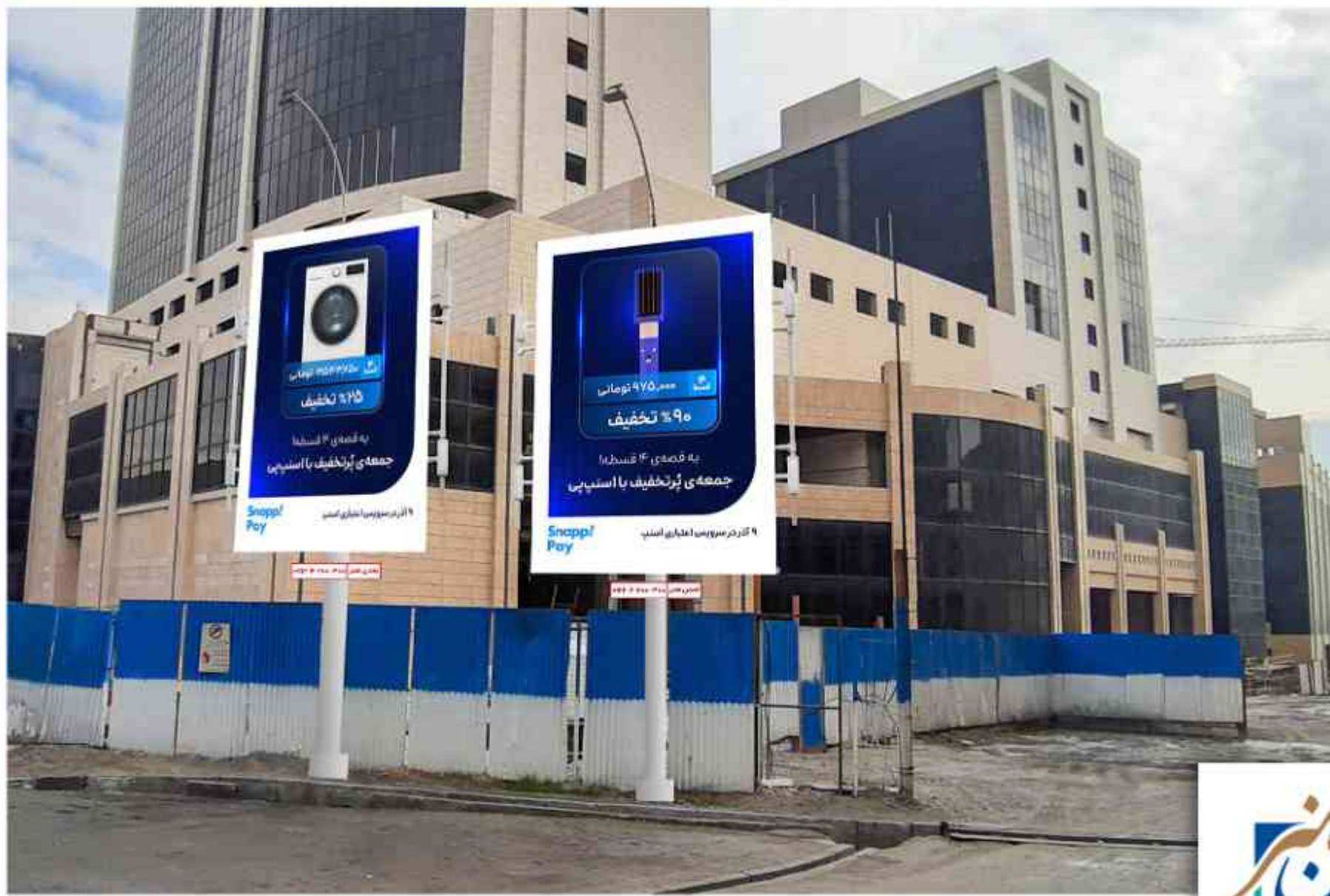
بزرگراه باکری، شمال به جنوب، انتهای خیابان ارم، جنب پارکینگ هایپر استار (سازه اول)
